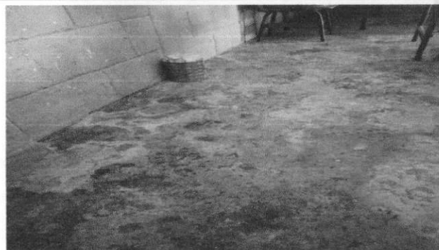
Foto 4: Sustitucion de Piso por Azulejo
