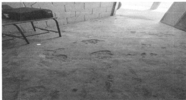
Foto 3: Sustitucion de Piso por Azulejo
