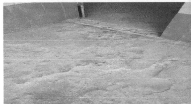
Foto 6: Sustitucion de Piso por Azulejo
