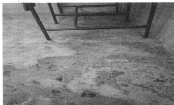
Foto 5: Sustitucion de Piso por Azulejo
