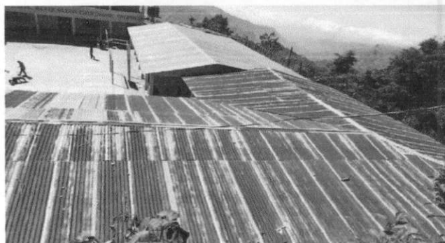
Foto 2: Sustitucion de Techo
